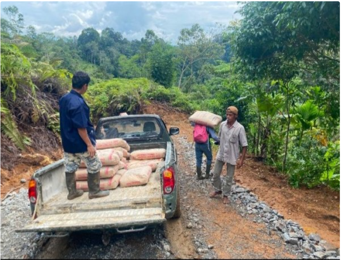
Gotong Royong Satgas TMMD dan Warga Agam Lancarkan Material Pengecoran
